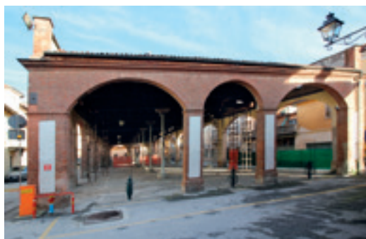
Vista della tettoia dall'esterno
