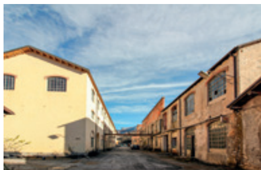
La cartiera e gli edifici circostanti in stato di abbandono
