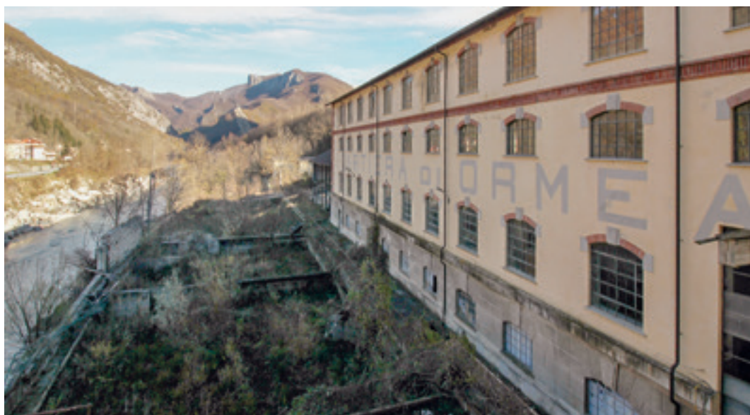
Vista della facciata
