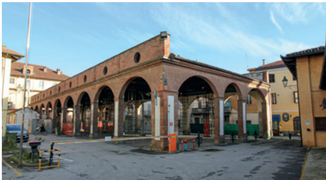
Vista della tettoia dall'esterno
