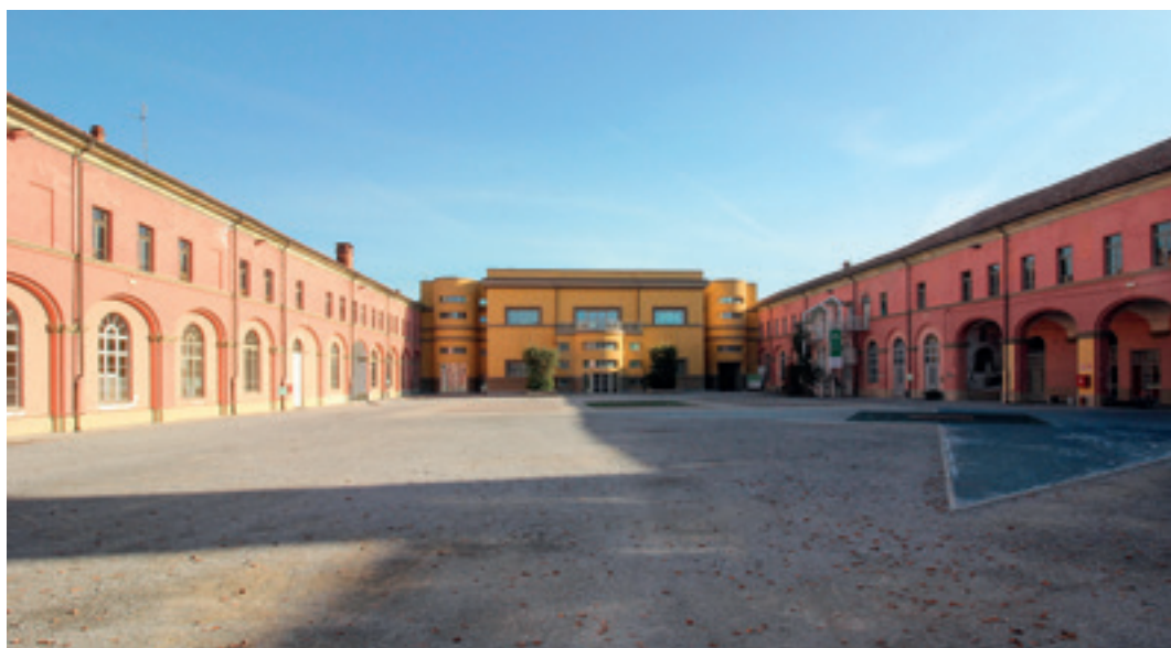
Il cortile interno del complesso visto dall'ingresso principale
