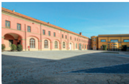
Vista della manica attualmente non utilizzata
