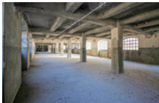
Lo spazio interno al primo piano
