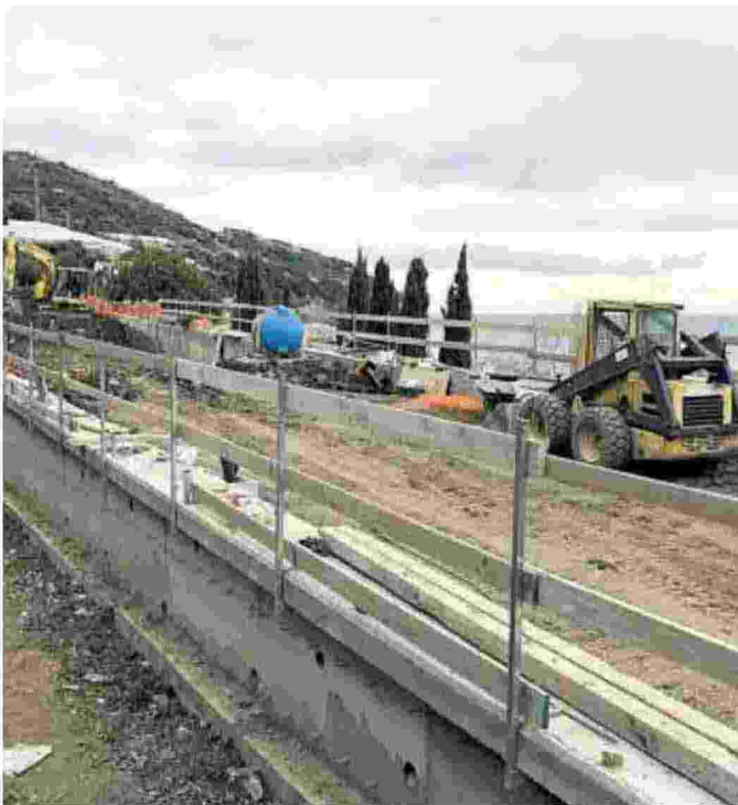
Lavorio in corso per la nuova ciclopedonale a San Lorenzo al Mare
